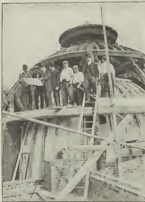
París.—Estudiantes trabajando en la terminación del edificio de su asociación en substitución de los obreros declarados sin huelga. (De fotografía de M. Branger.)
